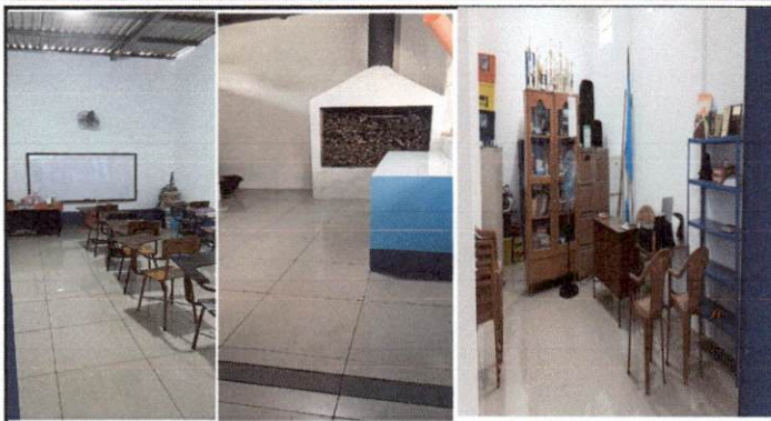
Foto 2: Sustitución de cerámica
