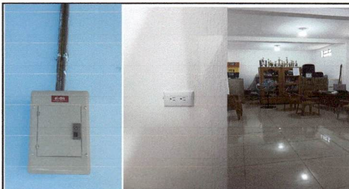
Foto 4: Reparación del sistema eléctrico
