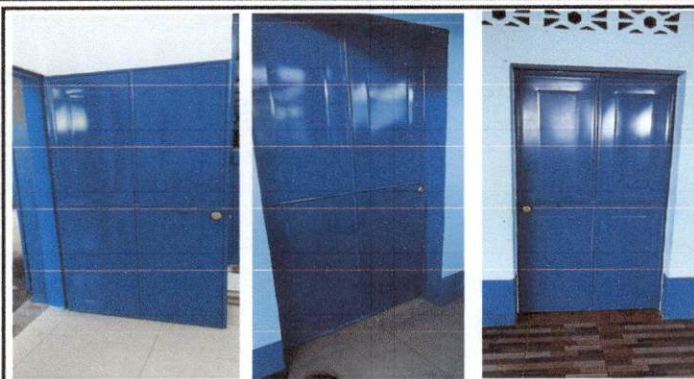
Foto1: Sustitución de puertas
